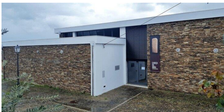
Figura 6 - Centro Interpretativo do Cabeço da Mina
